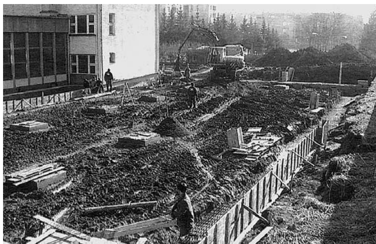
Ebédlő és tornacsarnok épül
